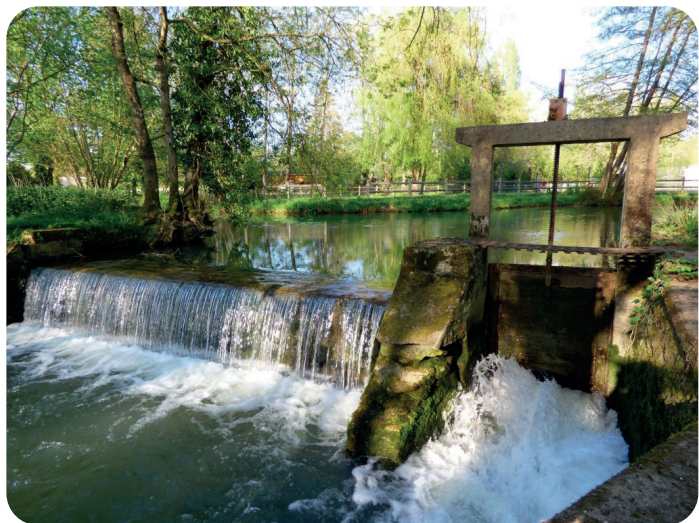
© Déversoir du Nahon - Vicq-sur-Nahon
