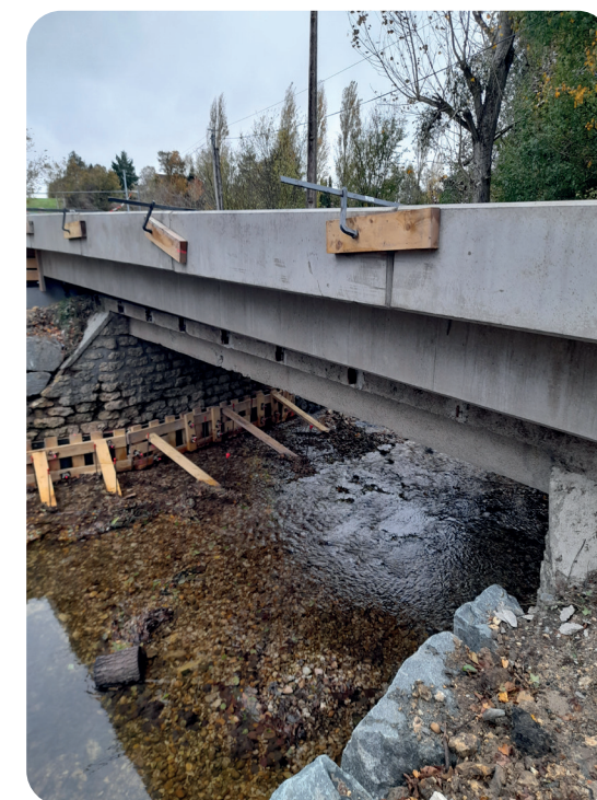
©CCEV - Pont de Courcueil Après
